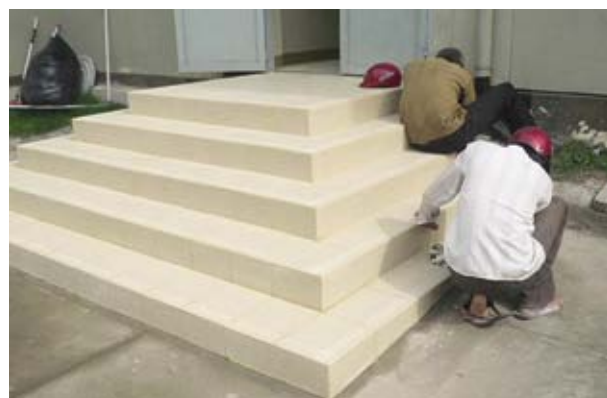
日本人学校玄関補修
