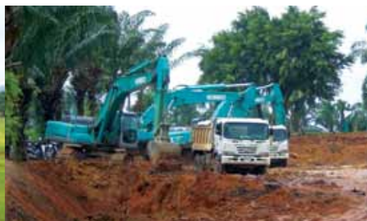
建設機械工事現場
