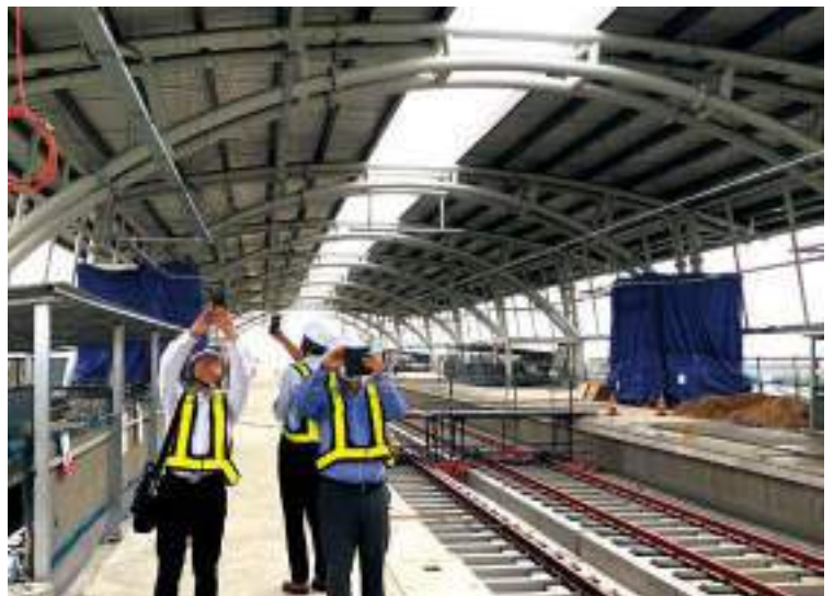
地下鉄工事現場視察(2021年1月14日)
