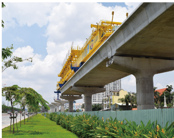
架設機械で一つずつブロック(セグメント)を架設
